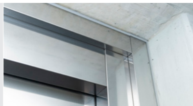
Painel entre a estrutura da porta e a parede
