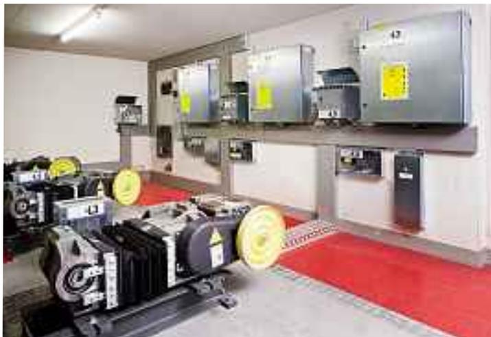
Instalação comercial em Triplex com a tracção DR SGB 142 em conjunto com um comando CO MX
