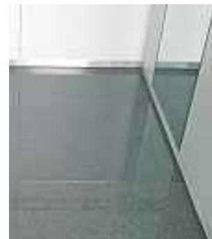
Pavimento: Granito artificial negro
